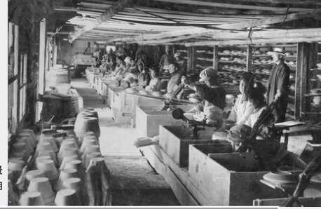
動力ろくろによる製陶風景 大正時代～昭和時代初期
